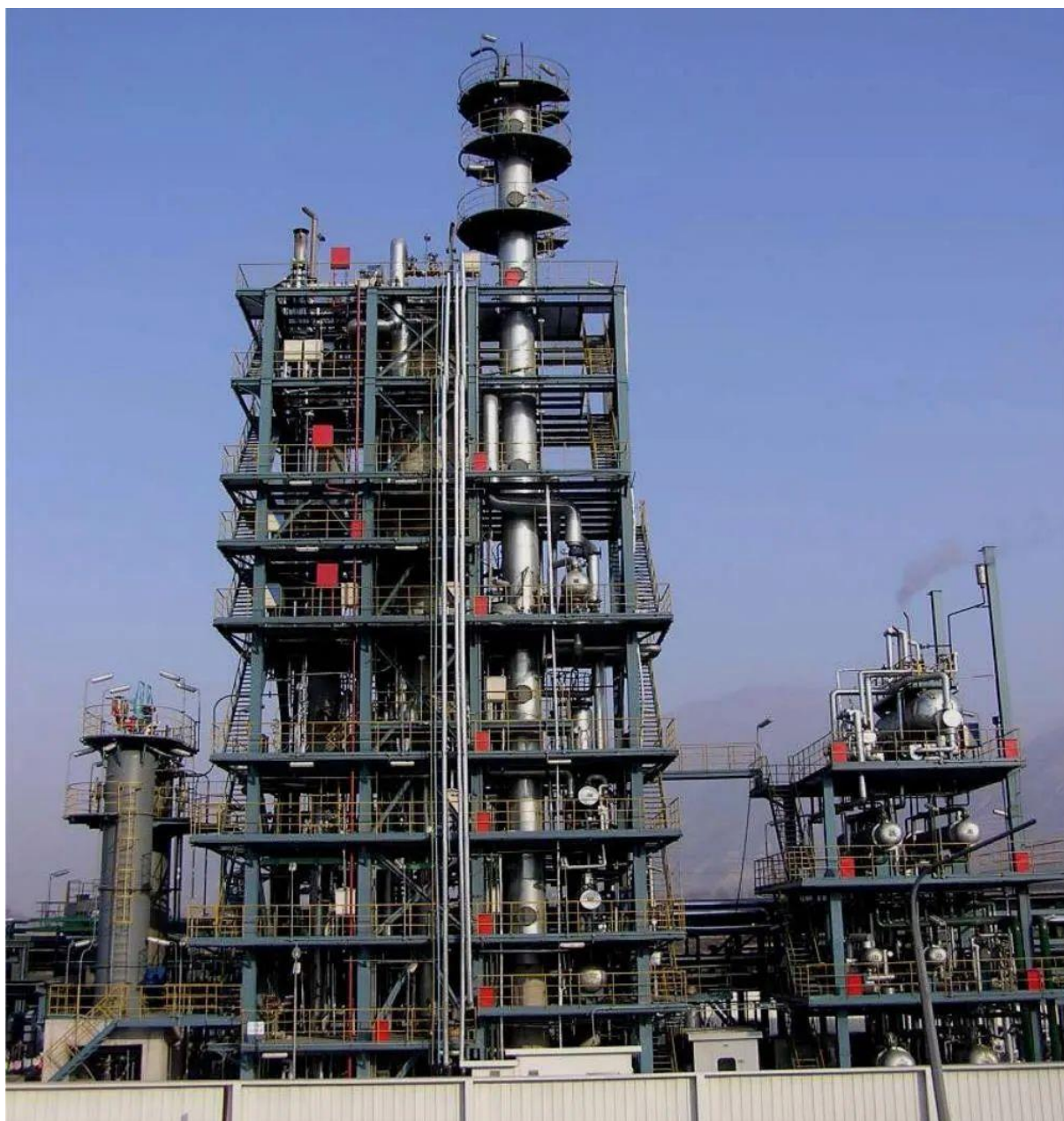
图 4 甲醇处理能力 50t/d 的甲醇制烯烃(DMT0)中试装置
