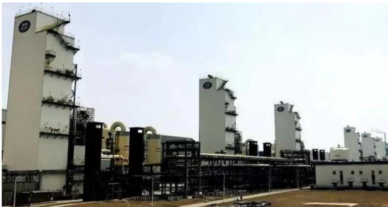
(a) 10万Nm 3 /h大型空分设备
