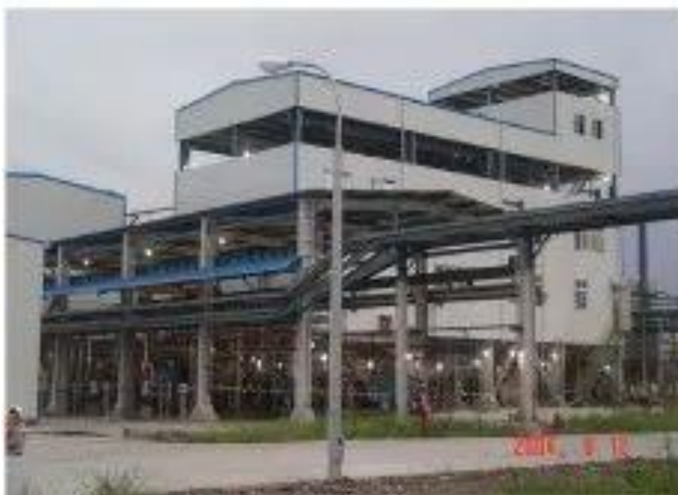
图 1 原料煤处理能力 6t/d 的煤直接液化制油中试装置
