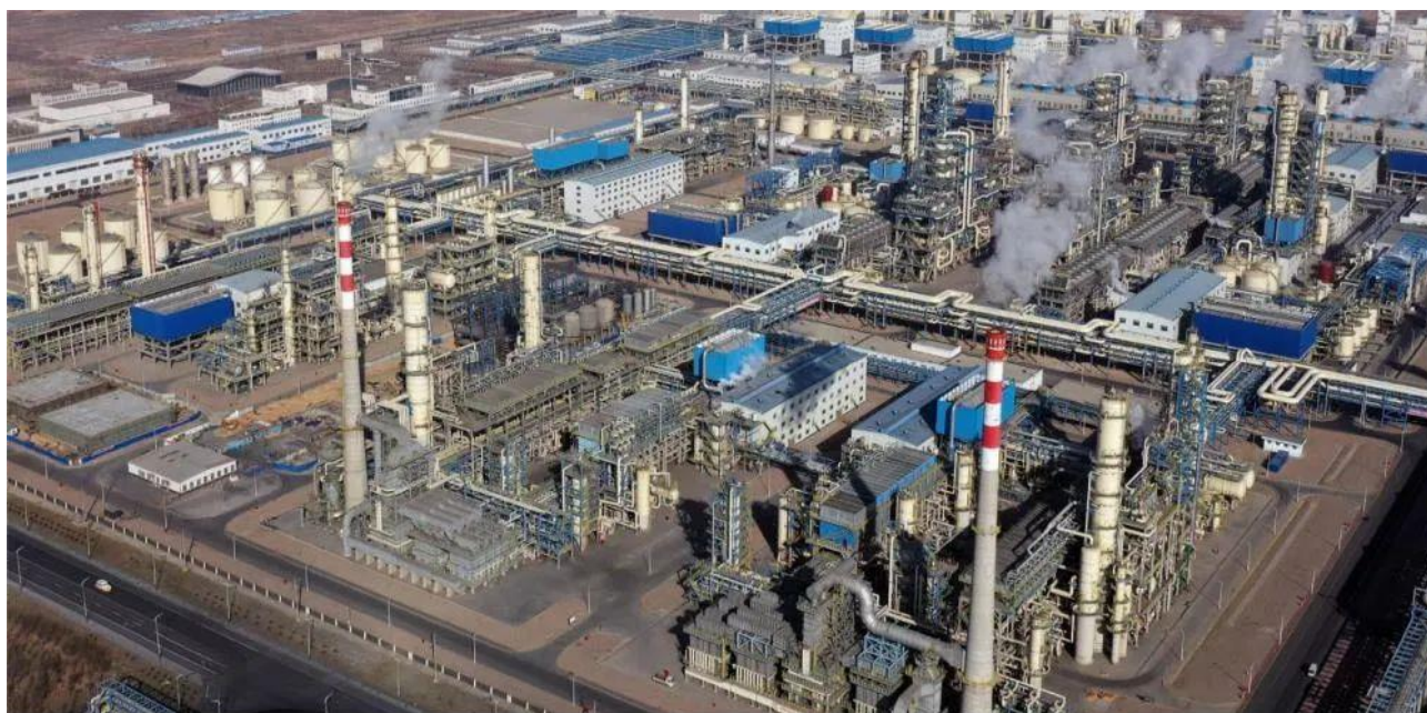
图 25 宁东 400 万 t/a 产品煤间接液化制油工业化升级示范项目
